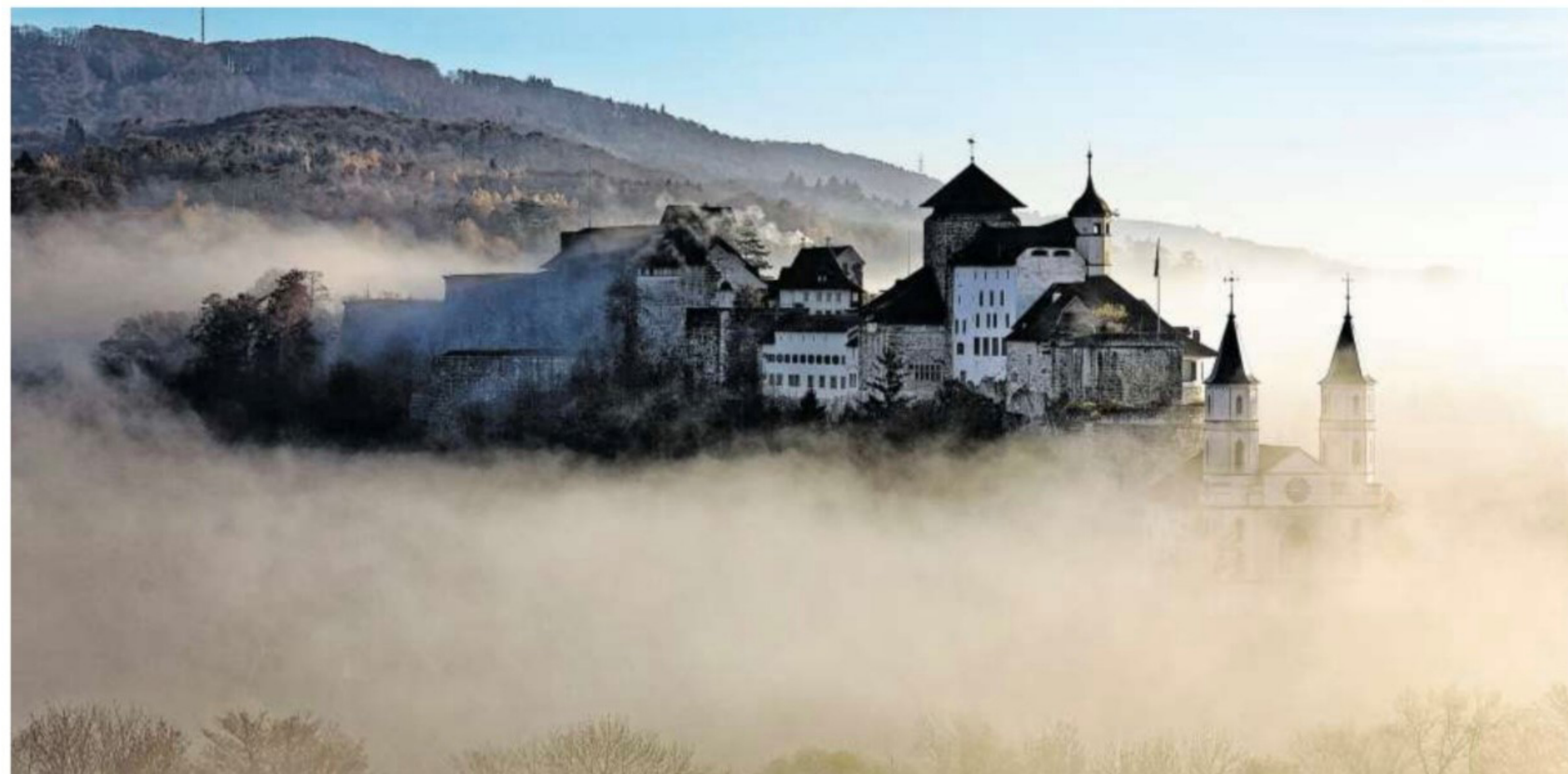
Die Festung Aarburg beherbergt aktuell noch das kantonale Jugendheim. Doch wie lange noch?
