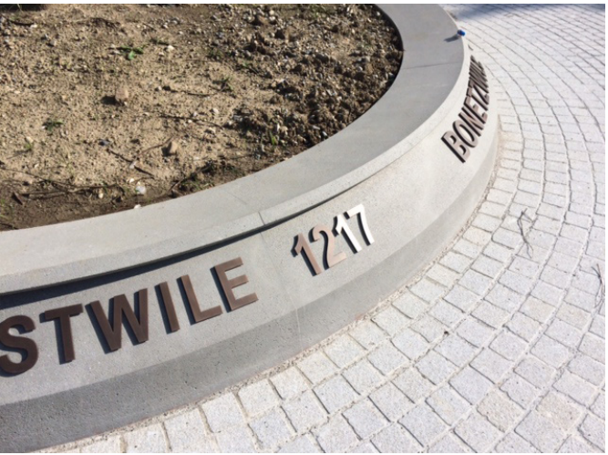
Betonelement mit historischen Ortsnamen
