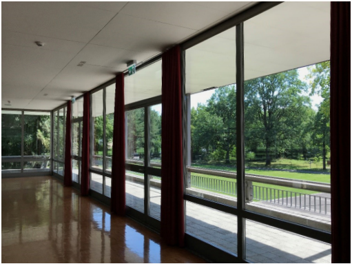
Aula Fassade Obergeschoss
