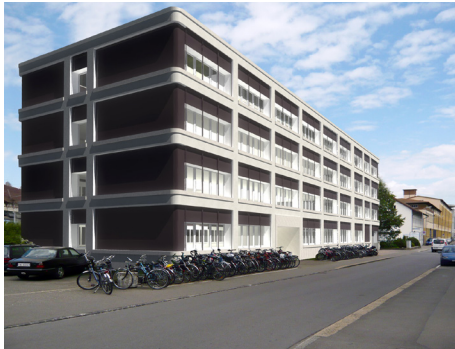
Ursprüngliches Farbkonzept der neu strukturierten Fassade
