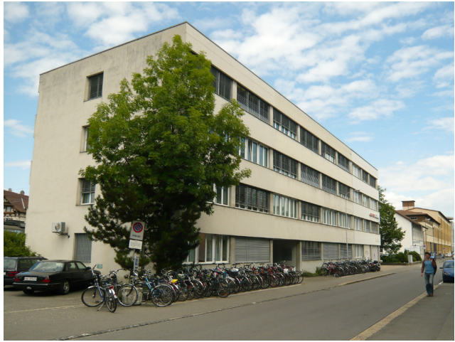
Das Haus vor dem Umbau mit Fassade und „Brandmauer“
