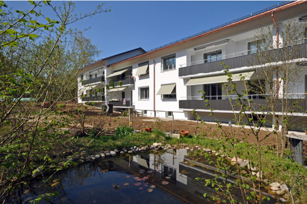
Ansicht von Südwesten / Fotografie: Roger Frei, Zürich
