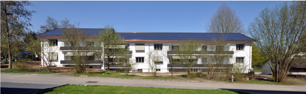
Das Photovoltaikdach deckt 78% des Gesamtenergiebedarfs / Fotografie: Roger Frei, Zürich
