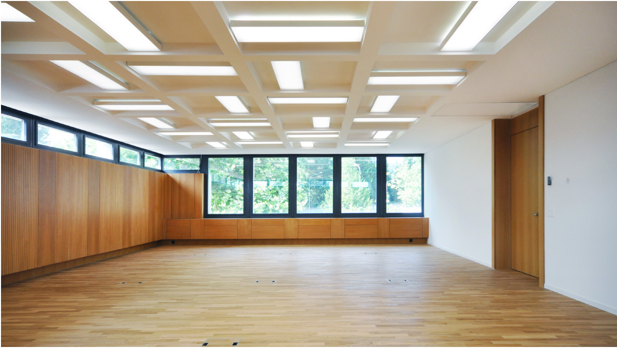
Reliefartige Anwendung der Akustik- / Beleuchtungspanels
