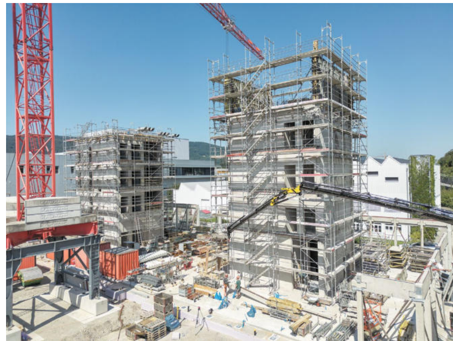
Bürogebäude und Parkhaus im Tell-Ost, Aarau
