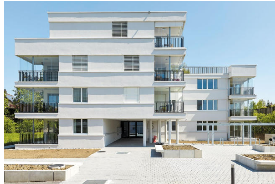
Wohnüberbauung Grabenstrasse in Aarau-Rohr
