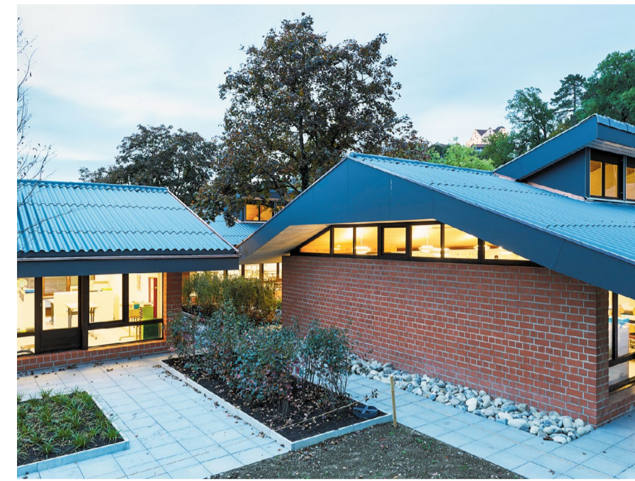
Denkmalgeschützte Sanierung Pavillonschule in Mörken-Wildegg
