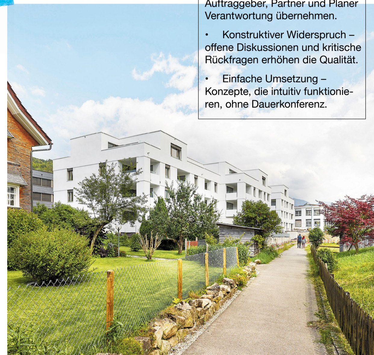
Zwei Mehrfamilienhäuser mit Einstellhalle in Ebnat-Kappel
