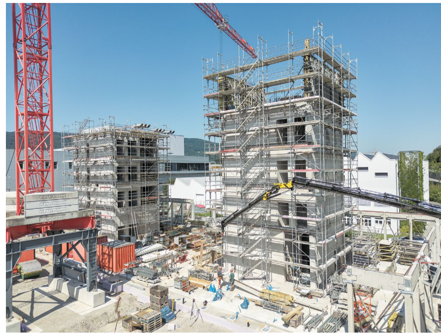
Bürogebäude und Parkhaus im Tell-Ost, Aarau
