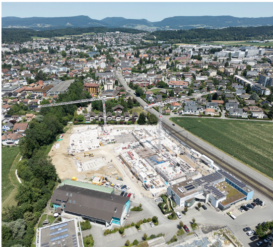
Baufortschritt Juni 2025 Fotograf Goran Potkonjak
