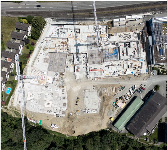
Baufortschritt Juni 2025 Fotograf Goran Potkonjak
